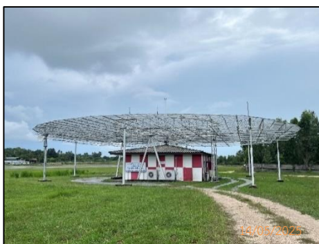
ภาพถ่ายที่ 1.4-8 สถานีเครื่องช่วยการเดินอากาศ DVOR/DME
