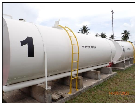
ถังน้ำสำรองสำหรับการดับเพลิง
